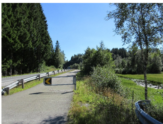
Figur 6 Dagens gangveg langs Gaulelva
