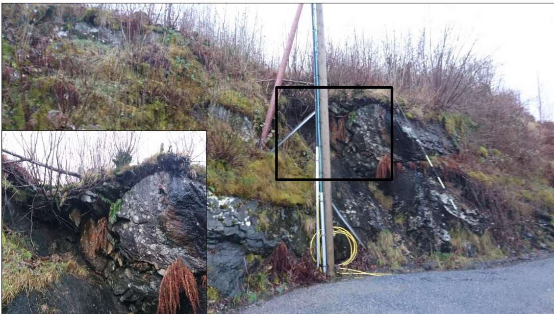
Figur 6: Bergskjæring med avgrensede partier i topp.
