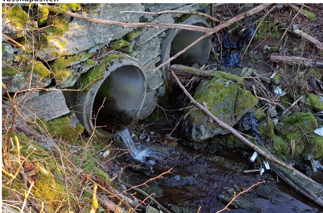
Figur 7.9.2: Utlaup for bekk under E39 (Statens vegvesen, 2018)
