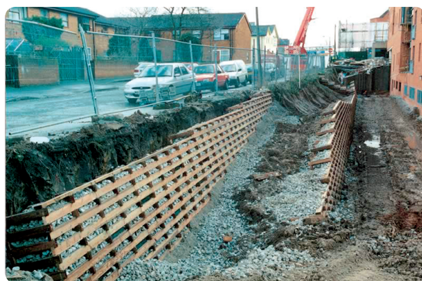
Fig. 7 b Bingemurer av tre for etablering av fortau på et lavere nivå enn veien den ligger langsmed. Foto: www.pccconstruction.co.uk
