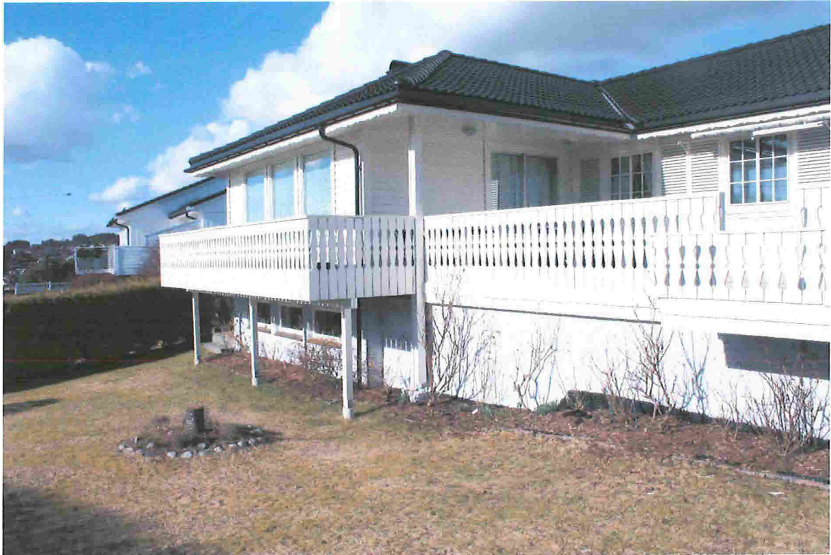
Fasade mot sør/vest. Bilde tatt fra hagen mot ny altan og mot nabogrense.
