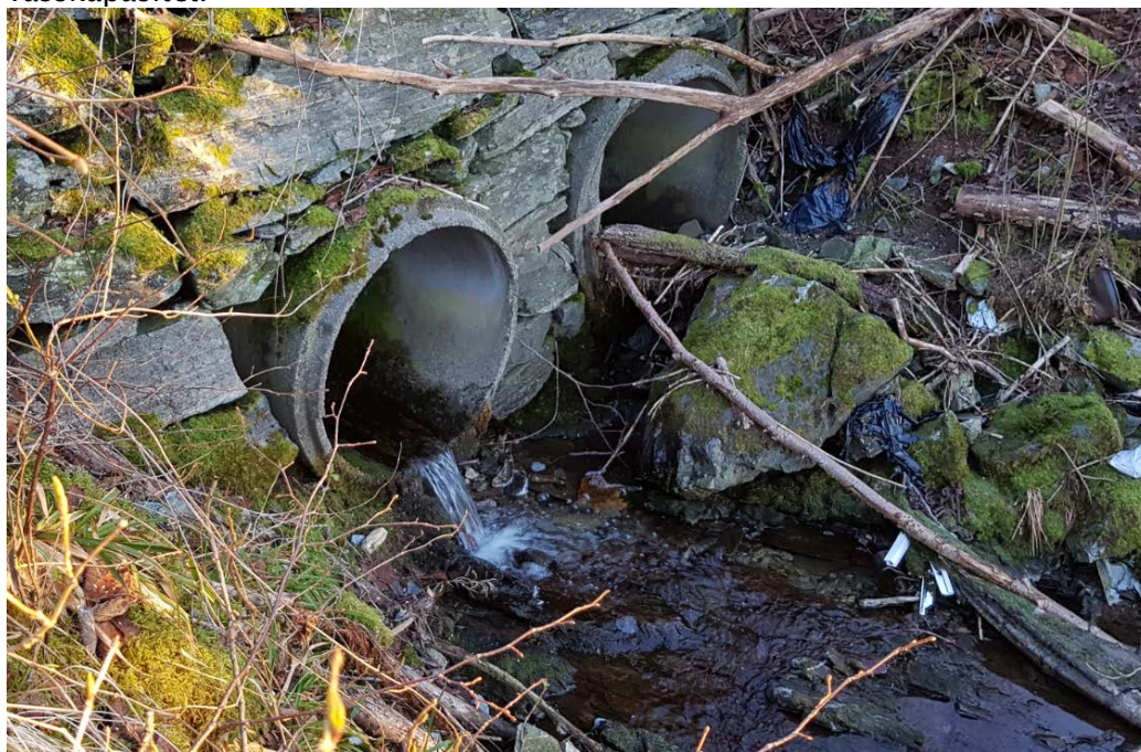
Figur 6.8: Utløp for bekk under E39 (Statens vegvesen, 2018)
