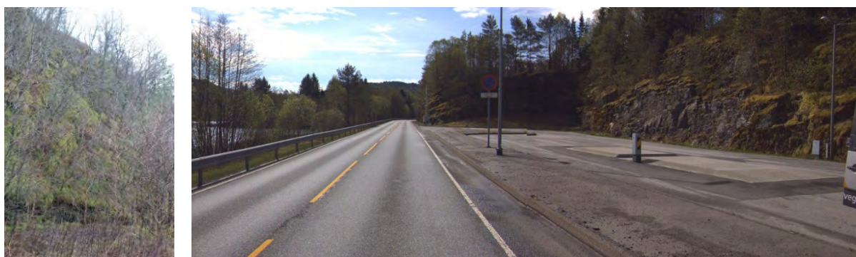
Foto til venstre viser eksempel på ein bergvegg med vegetasjon. Fotograf Kolbrun Oddsdottir, Statens vegvesen Foto til høgre viser fjellskjering ved Bashaugane og Torhaugen. Foto frå Vegbilder, Statens vegvesen
