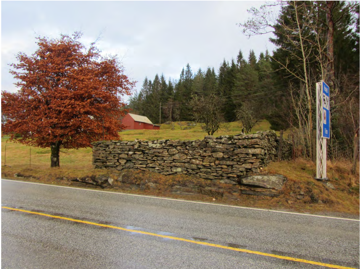
Tørrmur langs vegen på gnr./bnr. 99/7, Våge. Foto frå synfaring, fotograf Eilin Basset, Statens vegvesen
