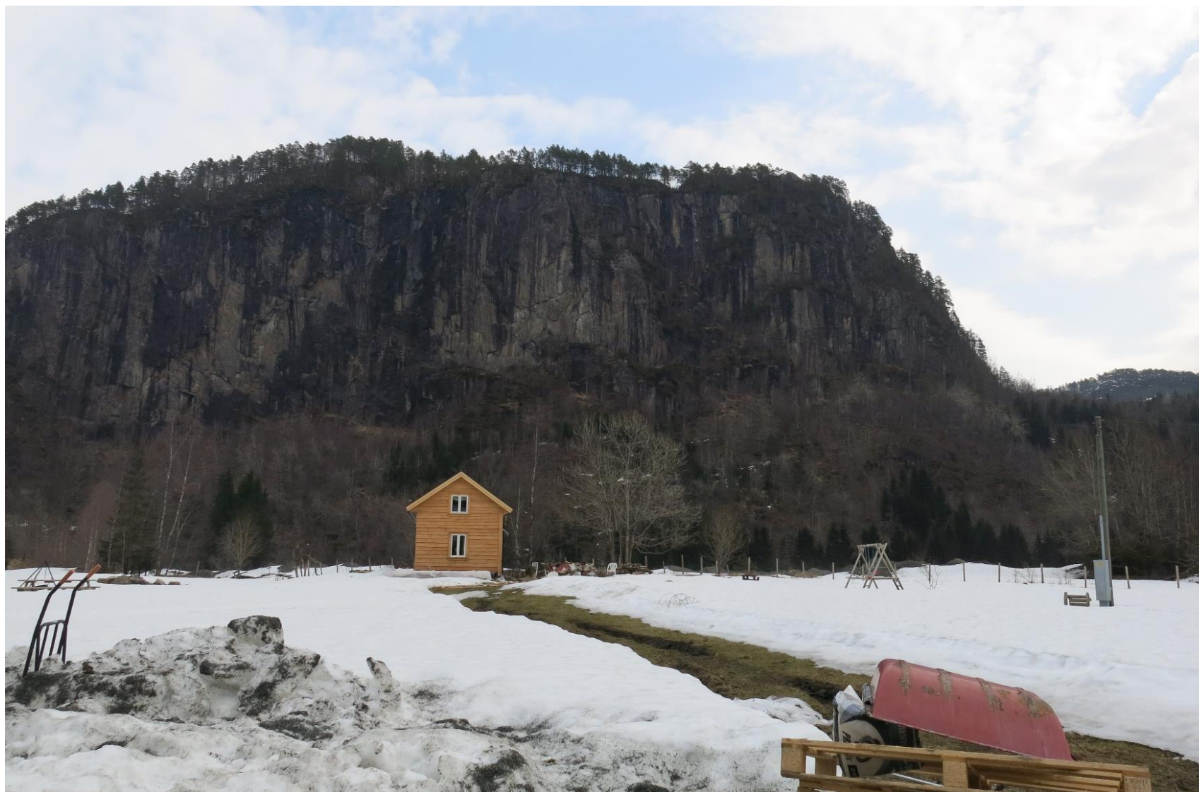
Bilde 3. Dyrskarfjellet med nær vertikale bergvegger. Bergmassen i fjellsiden virker homogen, men det er observert enkelte sprekkeavløste bergflak og mindre overheng i fjellsiden. Bildet er tatt fra Eikemo i retning mot øst.
