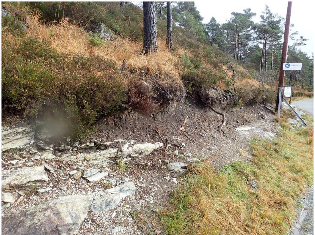
Bilde nr. 5 viser oppsprukket og avløst berg. Terrenghelningen er 25-30 grader bratt, og utgliding av blokker vurderes lite sannsynlig.
