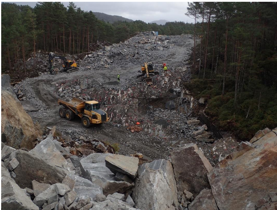
Figur 17: Arbeid på kabeltrasé i iledalen
