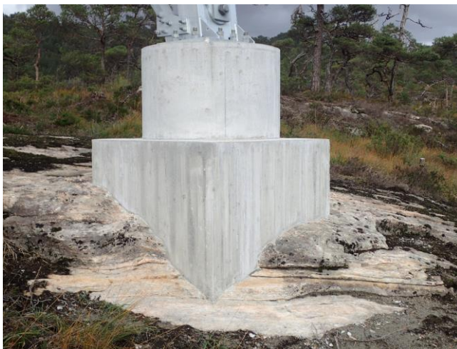
Figur 9: Estetisk vellykket fundamentering på fjell i dagen (M32)
