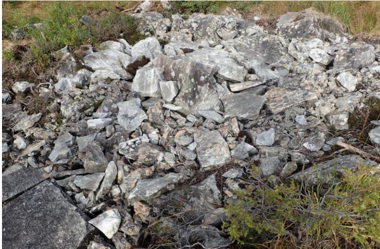
Figur 7: Grop etter revet 132 kV fjordspennmast er fylt igjen med stein
