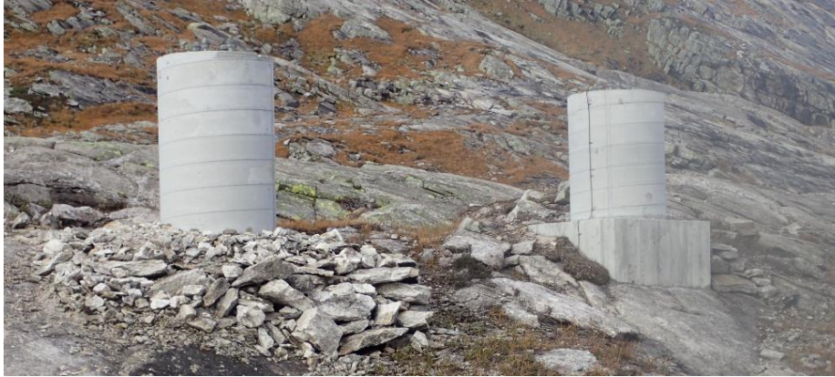
Figur 2: Eksempel på mastefundament hvor det ikke har vært mulig å skjule sprengstein, i stedet er sprengstein samlet rundt fundament (M40).
