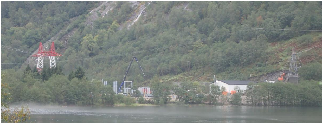
Figur 1: Steinsland koblingsstasjon under bygging. Mot vannet skal vegetasjon reetableres.
