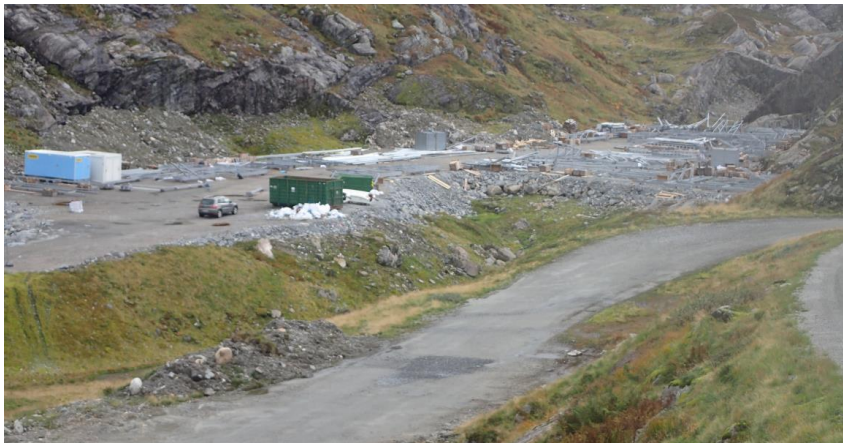
Figur 3: På riggplass 3 er det planert et stort areal.
