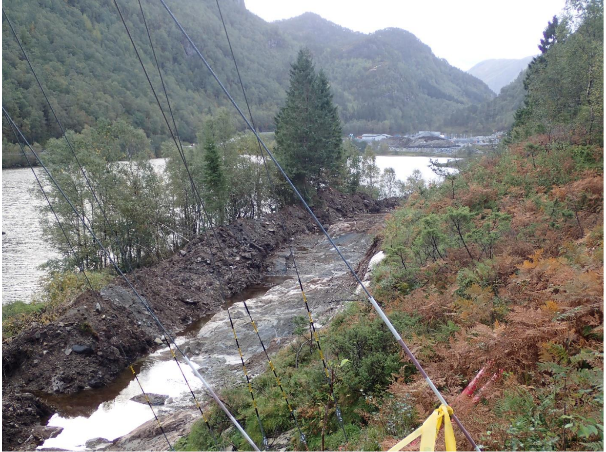
Figur 5: Bygging av ny adkomstvei, her er det spart noe vegetasjon mot vannet. Haugsvær stasjon i bakgrunnen.
