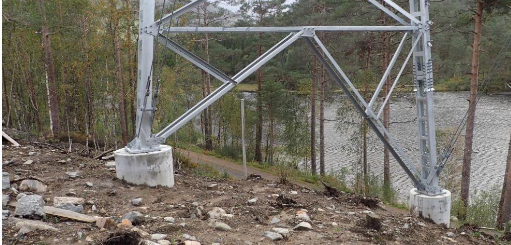
Figur 11: Mast M42. Skråningen skal replantes.
