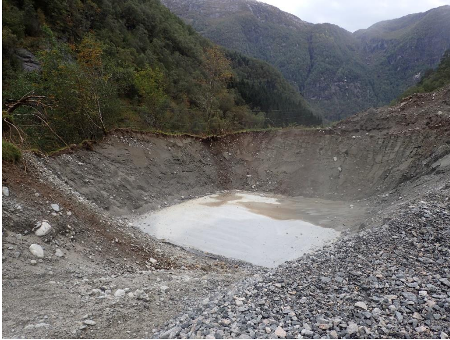
Figur 4: Byggegrøp på M4
