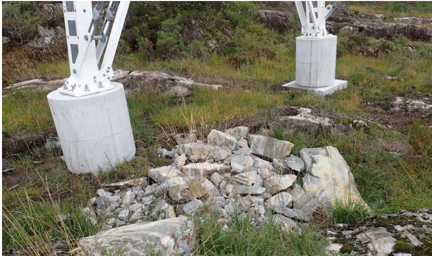
Figur 8: Istandsatt terreng og lagt under mast 31.
