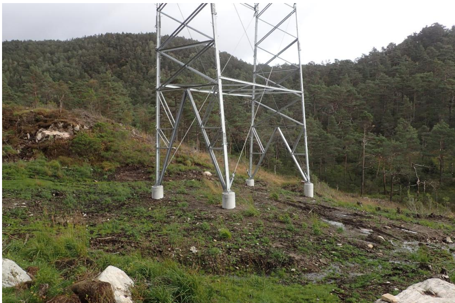
Figur 15: Mast 52 som er bygget på jordfundament
