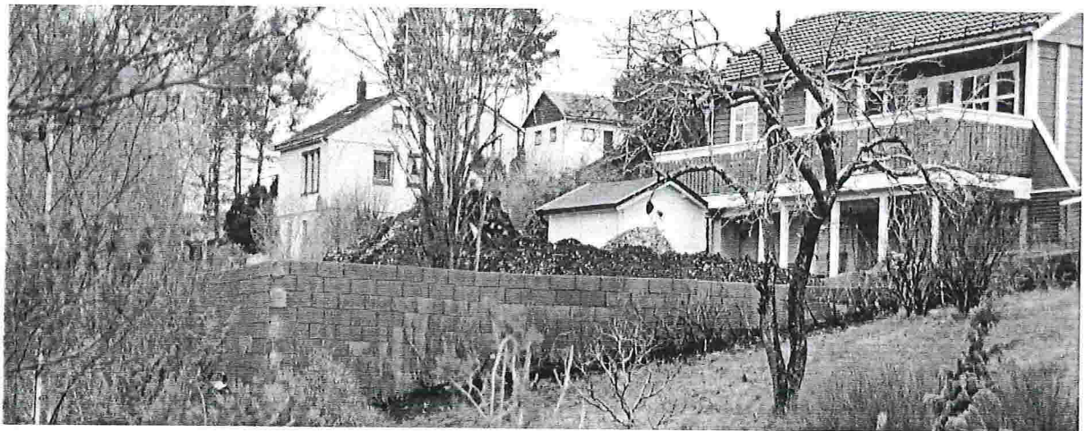
Forstøtningsmur, mot SØR-ØST
