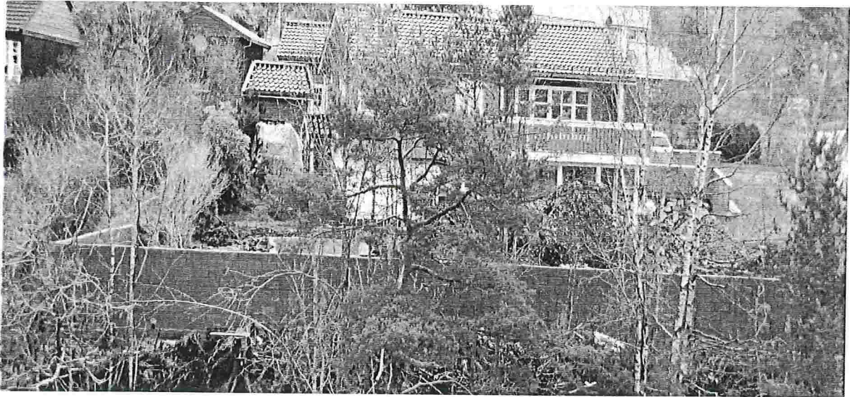
Forstøtningsmur , mot Fylkesvegen 392 ( mot SV )
