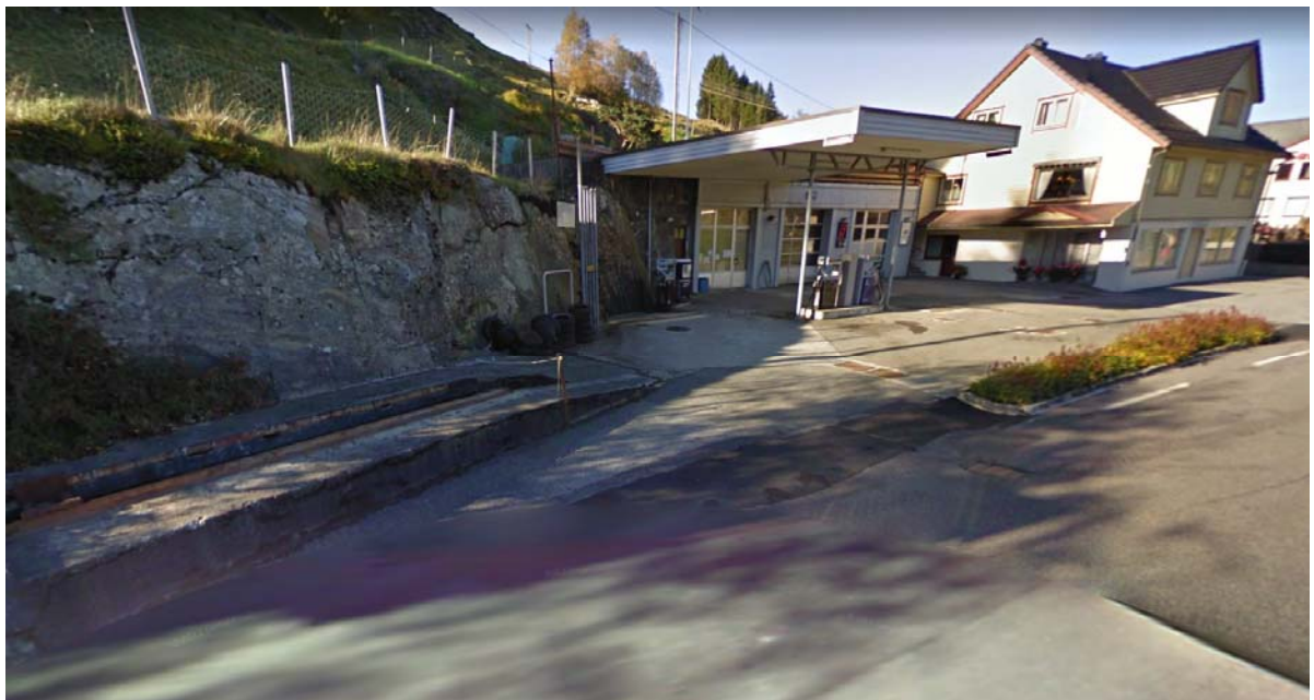
Figur 2 Stasjonen sett fra veien. (Kilde: www.google.maps.no ).
