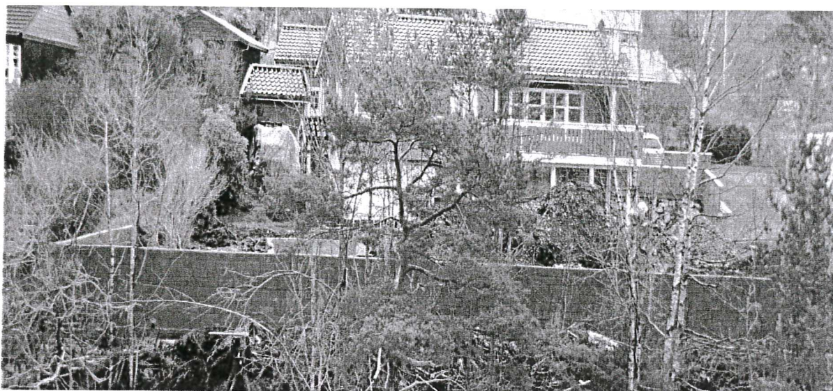
Forstøtningsmur , mot Fylkesvegen 392 ( mot SV )
