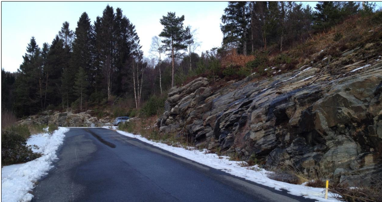
Figur 10: Fjellskjeringa langs tilkomstvegen til delområde B9 har område der det kan losna mindre blokker. Desse vil stoppa i grøfta og dermed ikkje nå ut i tilkomstvegen.
