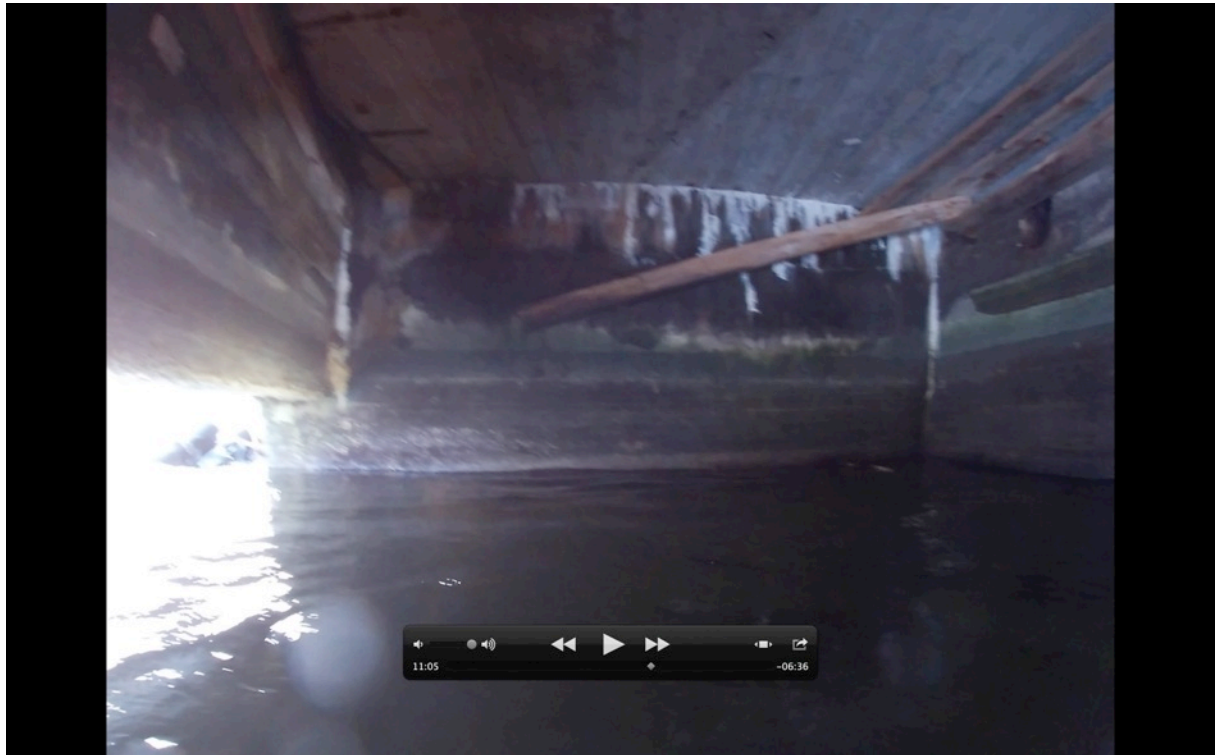
Bilde 13. Vegg ved D, sett fra C.
