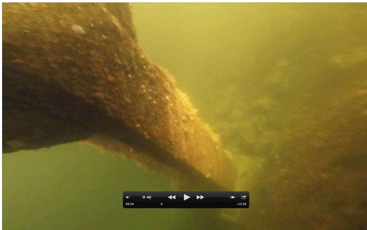
Bilde 42. Søyte mellom G-H.
