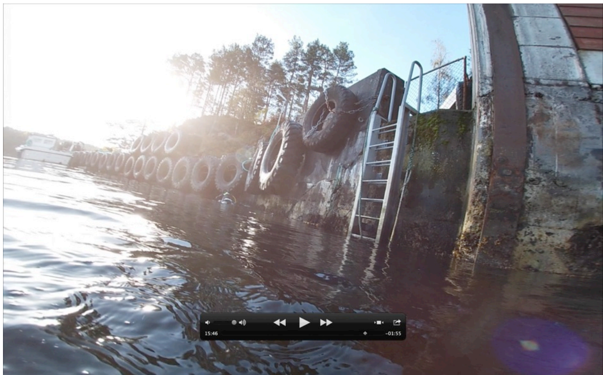
Bilde 25. Sett fra F, mot vegg mellom E-G
