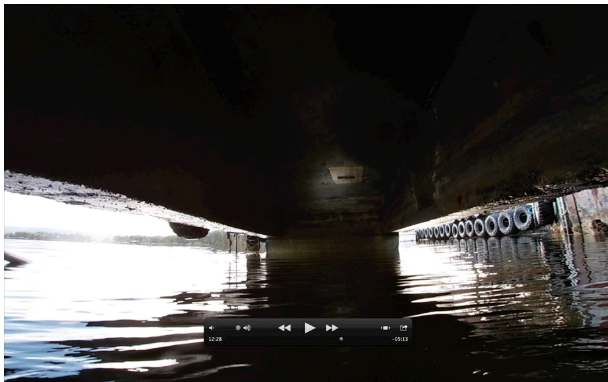
Bilde 19. Vegg ved E, sett mot F.
