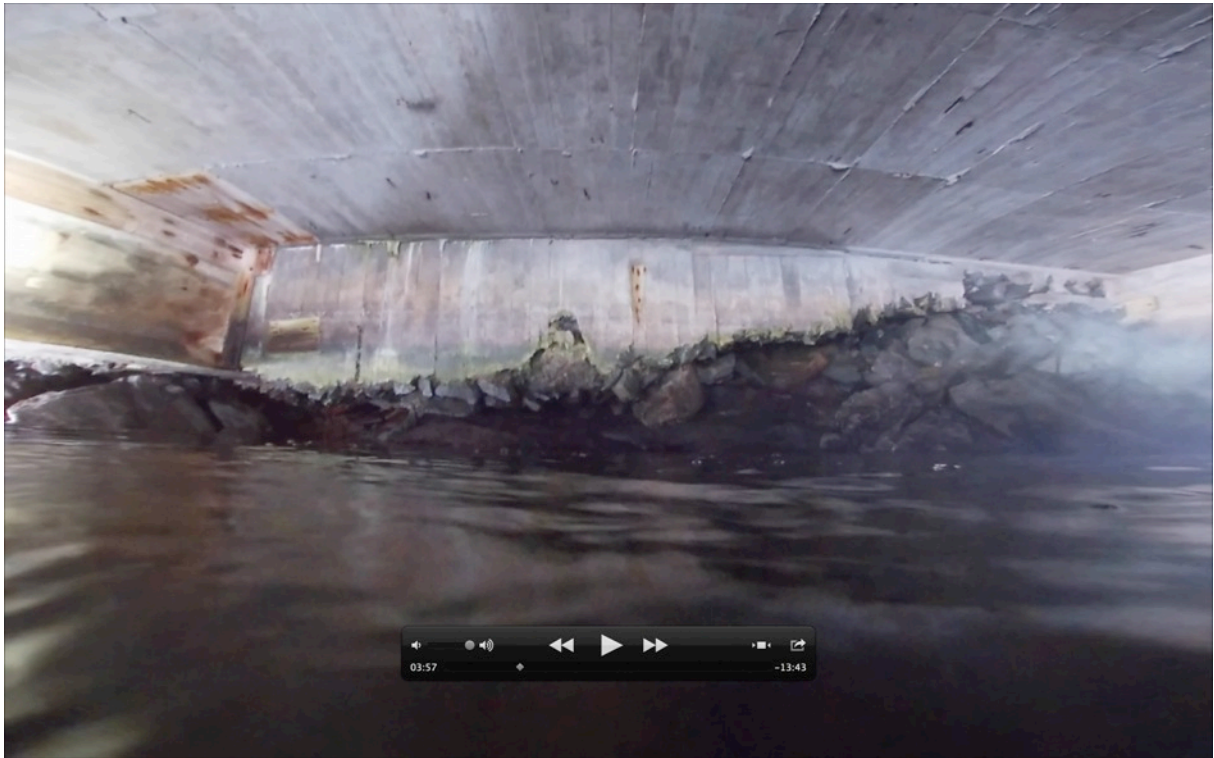
Bilde 43. Sett fra H mor bakvegg i betong/mur.
