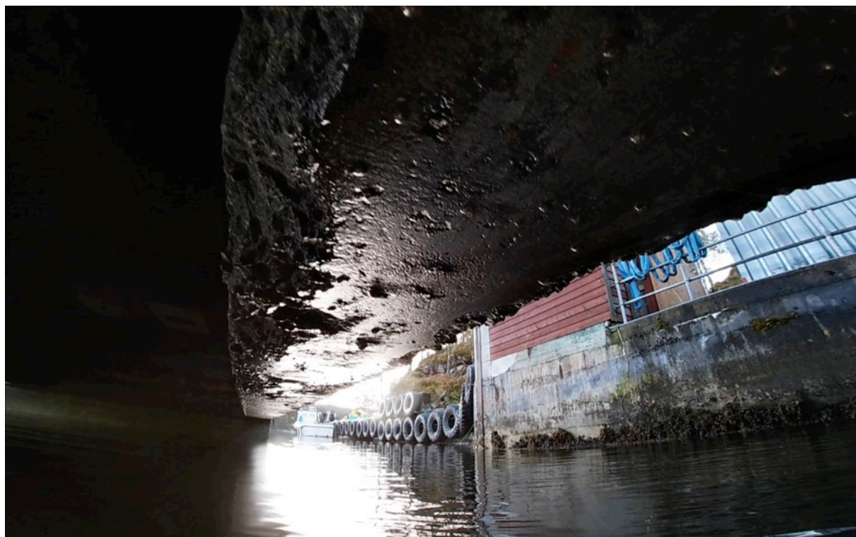
Bilde 17. Vegg ved E, sett mot F.
