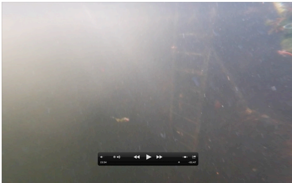
Bilde 26. Sett fra F, mot vegg mellom E-G
