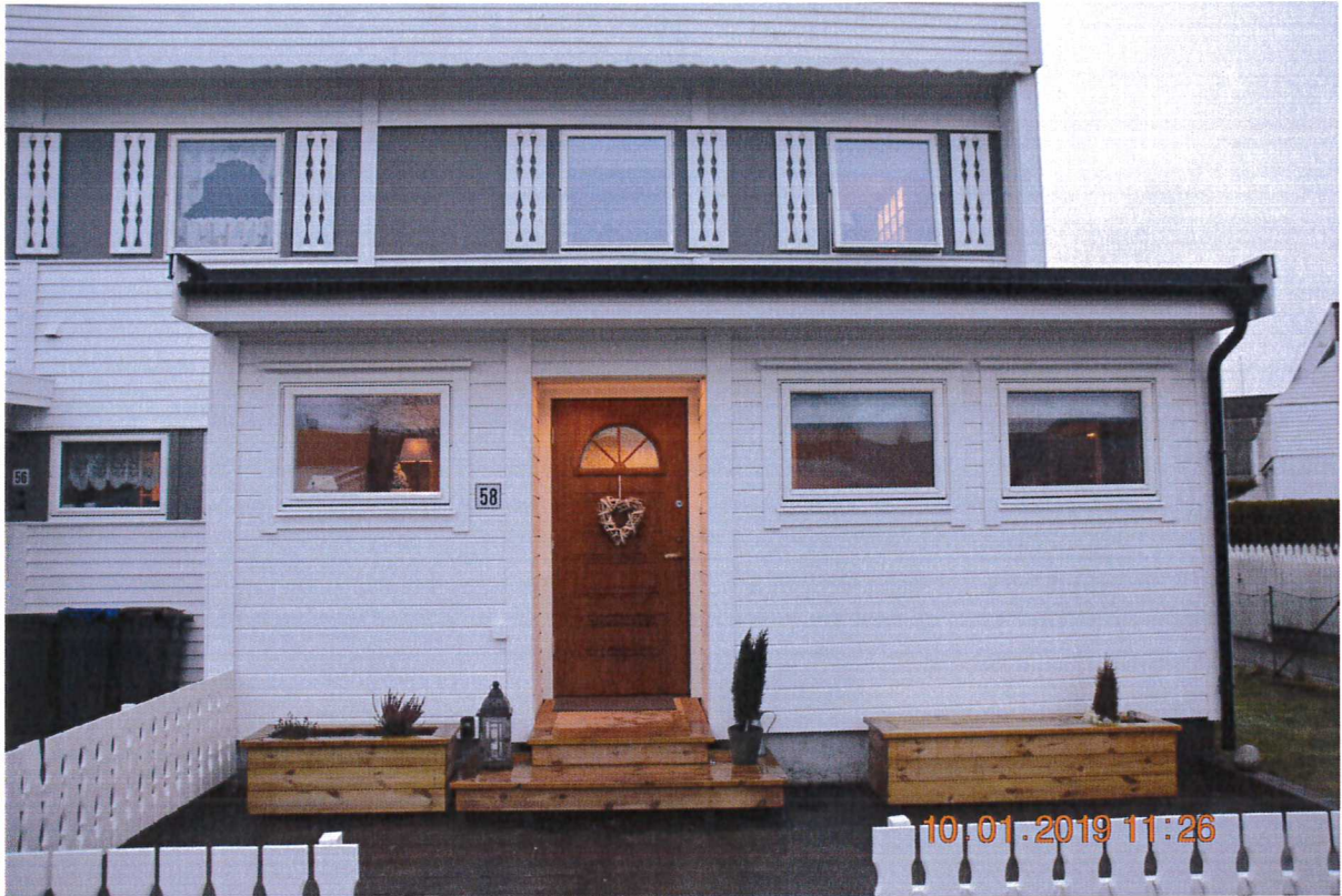
Nåv. situasjon på Bruvegen 58
