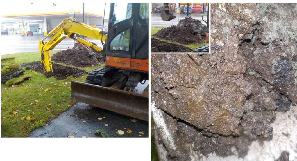
Figur 18. Bildene er tatt under sjaktning i punkt 28. Sjakten ble 2,5 m dyp. Flere bilder er tilgjengelig på forespørsel.
