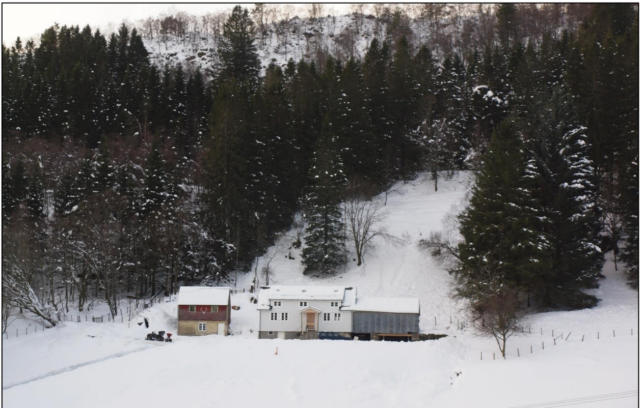
Figur 4-2. Søkket til venstre på bildet leder vann fra høyere i skråningen utenom bygningene.
