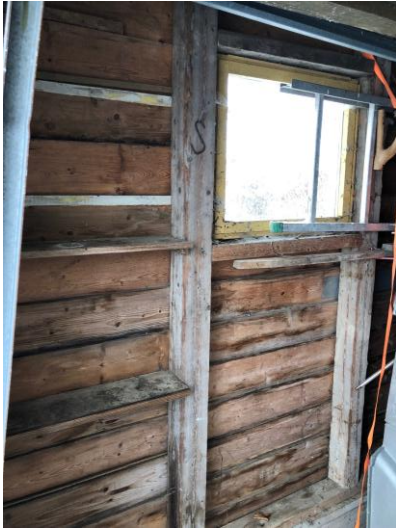
Vegg oppbygging garasje
