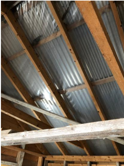
Ståltak plater garasje
