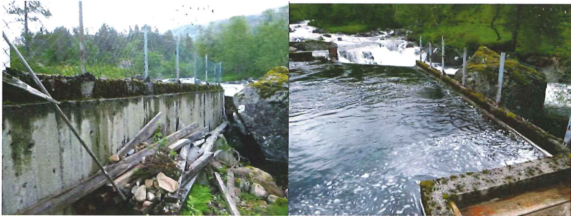
Figur 4 – Inntak til Nipo kraftverk og Kjeldebekken kraftverk
