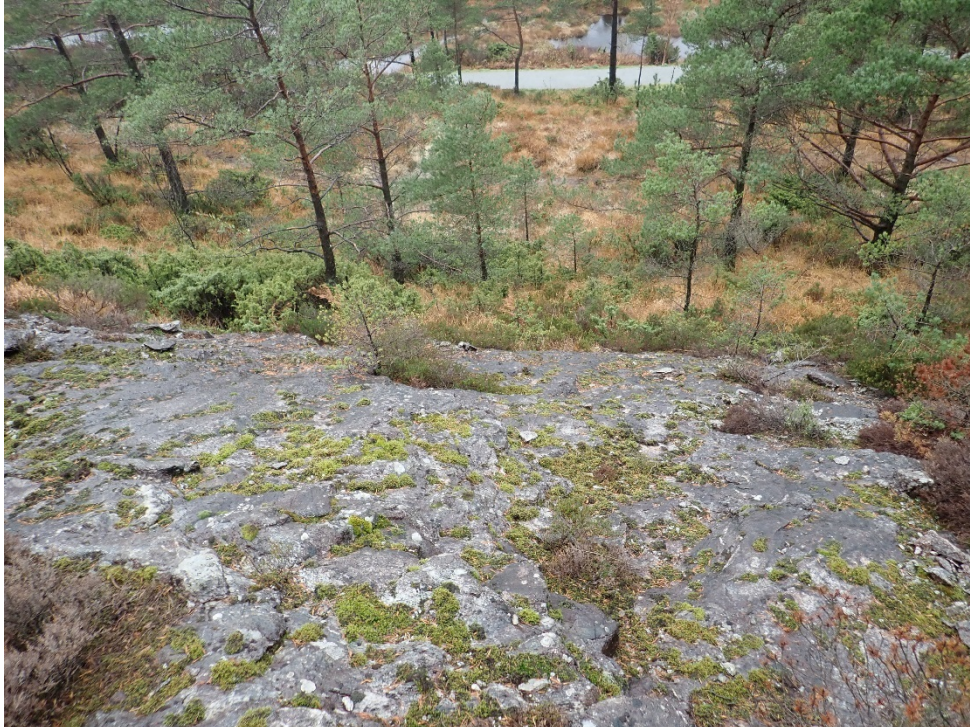
Bilde nr. 4. Bergblotning ned mot turvei på østsiden. Noen mindre blokker er avløst. Skråningen er ikke bratt nok til at blokker kan gli ut og få utløp mot turvei.
