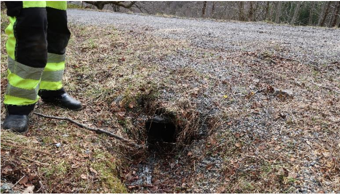
Figur 1 Innløp på kommunal stikkrenne
