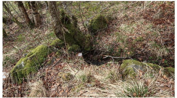
Figur 2 Utløp av stikkrenna og inn i røyr
