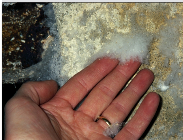
Saltkrystaller på murvegg.
