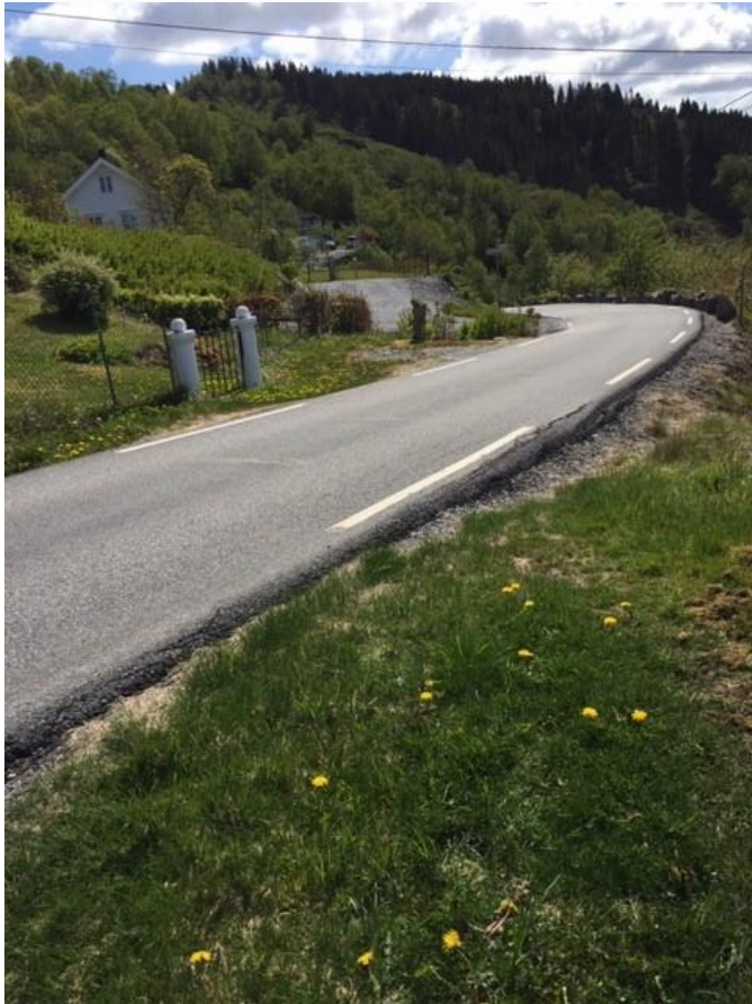
Foto viser sikt mot sør på FV 394
