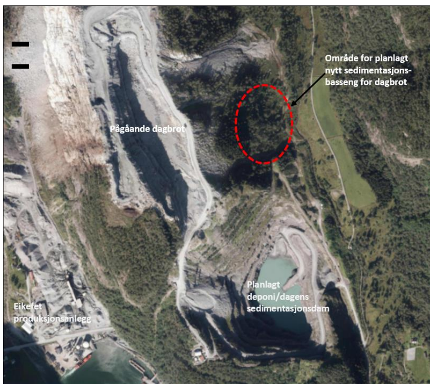
Figur 9-10: Flyfoto. Aktuelt område for nytt sedimentasjonsbasseng for sigevatn frå dagbrotet (ikkje planlagt avfallsdeponi) er markert med stipla raud linje. Kartgrunnlag: geocache.
