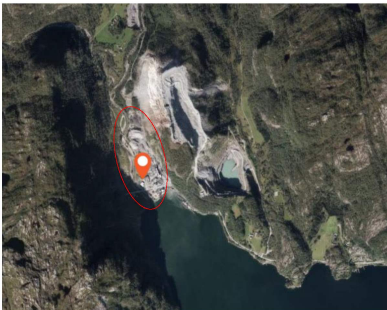
Figur 5-2 Flyfoto som viser det avslutta steinbrotet i sør og nytt steinbrot i nord. Kontorbygg, lagerhaugar og steinkuseverk tilknytt verksemda til Oster Pukk AS er lokalisert til området merka med raudt. Kjelde: Norgeskart.
