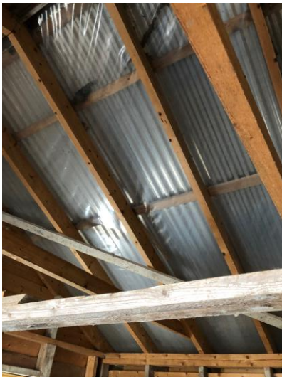
Ståltak plater garasje
