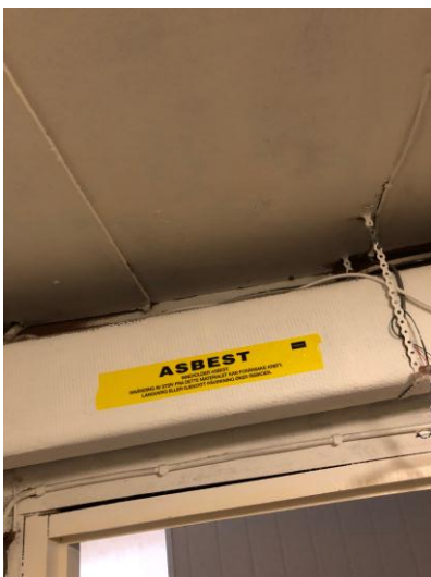
Ventilasjonskanal asbest
