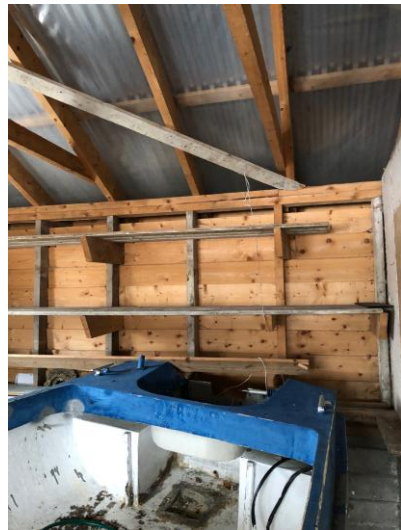
Vegg + stålblater garasje
