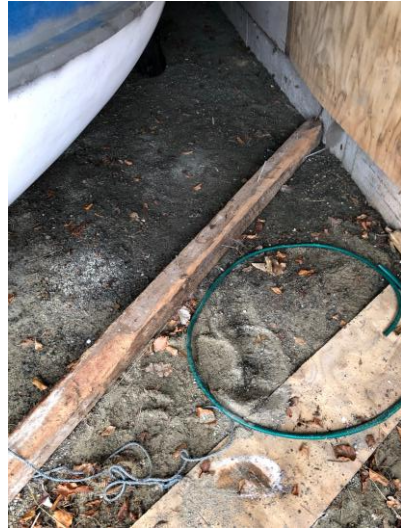
Gulv (sand) i garasje
