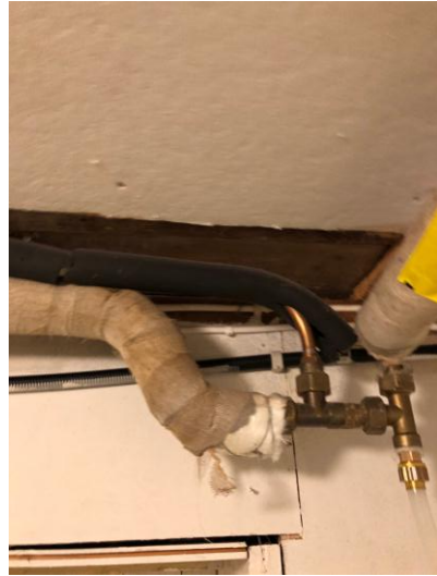
Prøvepunkt P2 av rørisolasjon
