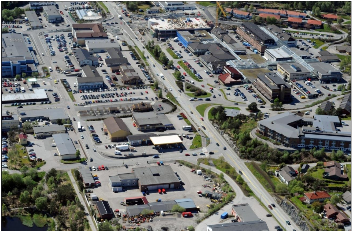
Skråfoto frå aust viser tydeleg dagens byggjestruktur og arealbruk.
