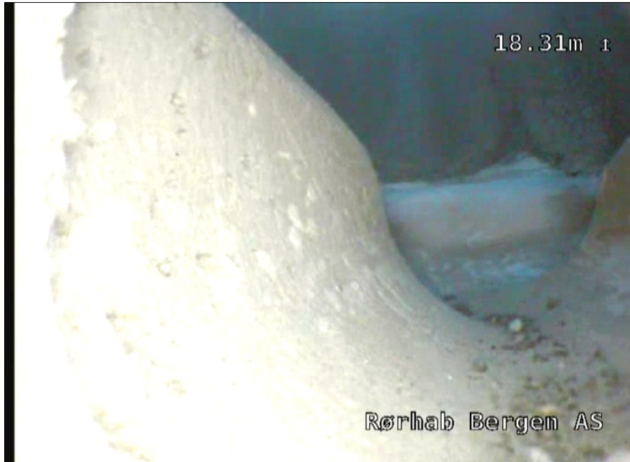
Foto: 4_1_4_07112017_203139_A.jpg 18,31m, Inspeksjon fullført -
