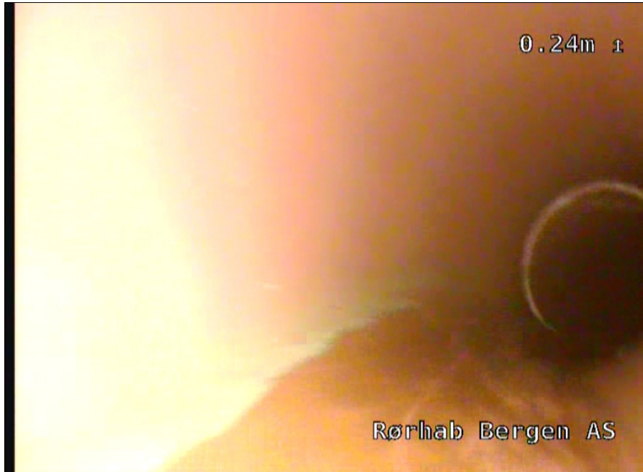
Foto: 1_1_1_07112017_194718_A.jpg 0m, Start inspeksjon -
