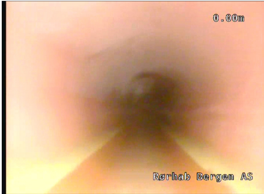
Foto: 2_1_1_07112017_200514_A.jpg 0m, Start inspeksjon -
