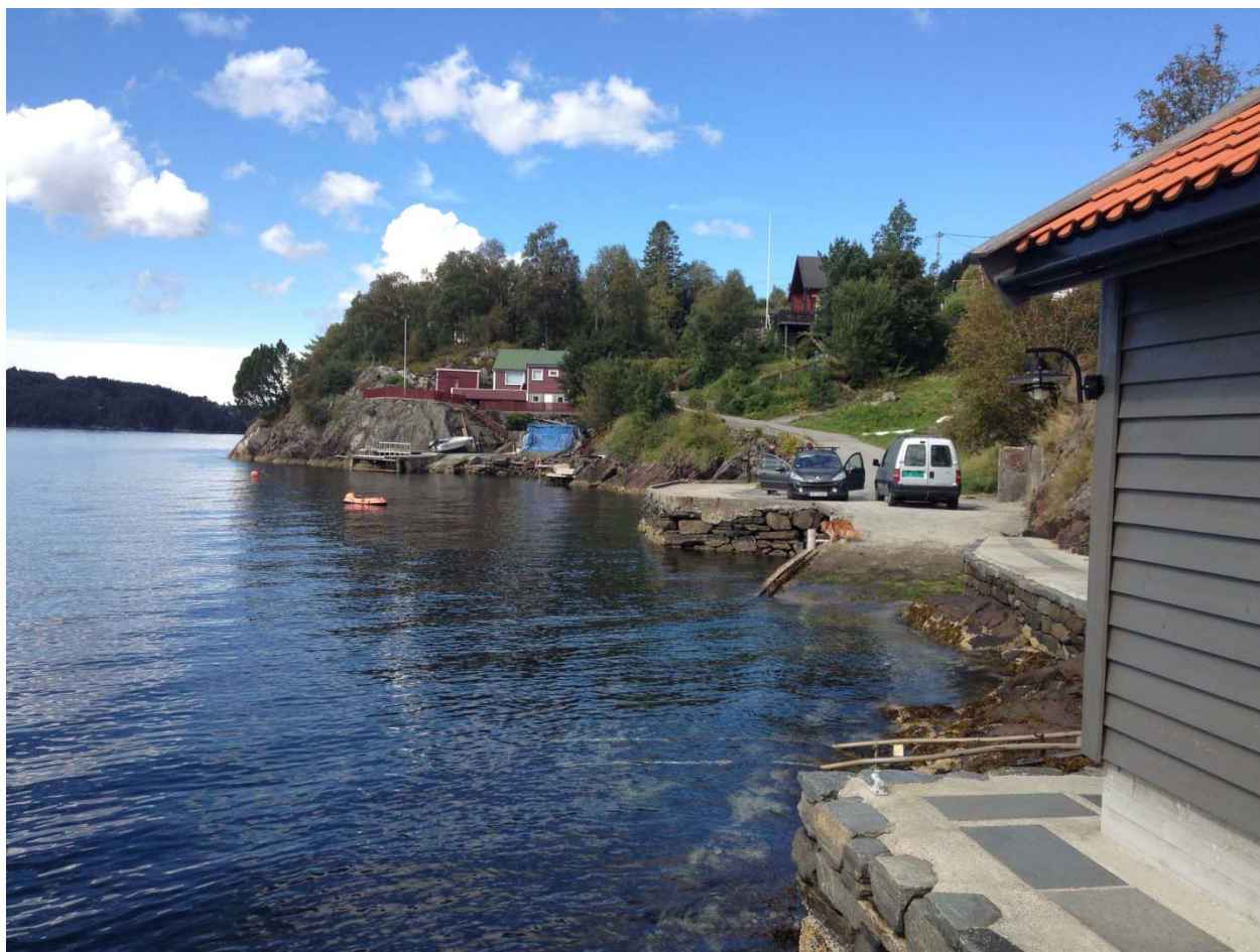
Figur 8: Nappesvik, eksisterende slipp og kai midt i bildet
