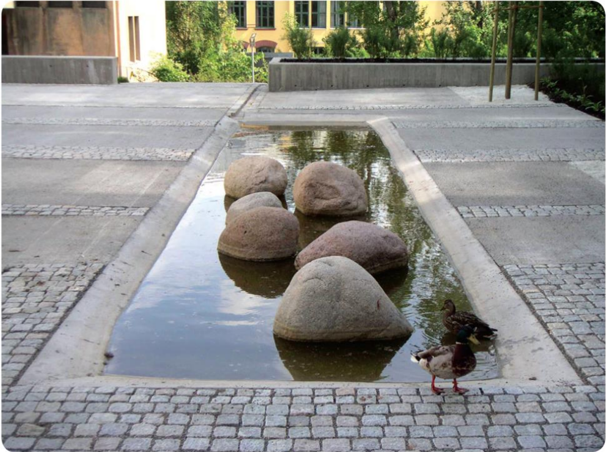
Figur 9. Åpent fordrøyningsbasseng. Overflatevann fra plassen samles i bassenget. Dette bildet er fra Pilestredet park i Oslo. Foto: SINTEF Byggforsk.
