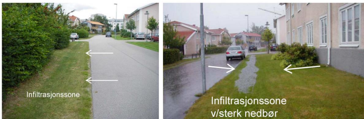
Figur 8. Eksempler på lokale infiltrasjonssoner for overvann langs veier ved boligområder. Foto: COWI/Gøran Lundgren
