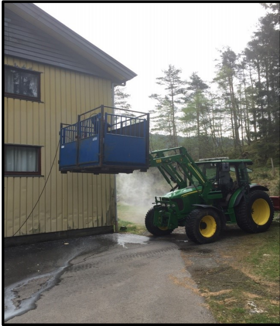
Høgtrykksspyling av veggen mot vest
