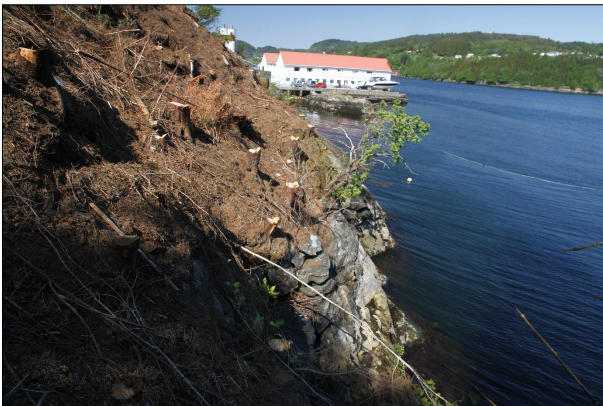
Fig. 21. I overgangen fra kulturmarksområdet til sjø i Remme-området går planlagt trasé gjennom en nylig uthogd granfelt og ned i en bratt strandsone og til en brådyp littoralzone. 25. mai 2018. Foto: A. Håland.
