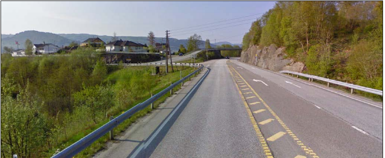
Figur 6.14. Krysset ved Mundal, sør for planområdet, mellom FV391 og E39/Osterfjordvegen.
