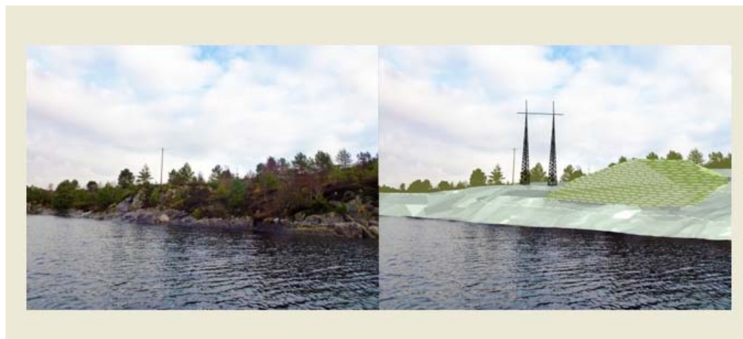
Figur 8 I landføringsområde for kabel sett fra sør. Terrenngmodell illustrerer ny mast og en løsning for plassering av overskuddsmasse
