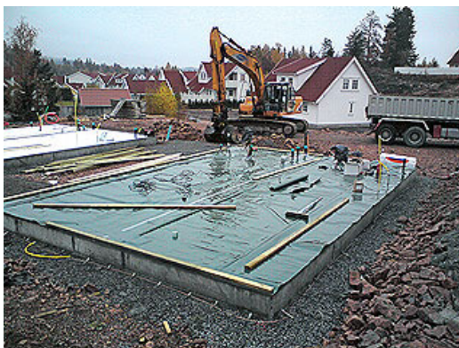
Fig. 01 Radonmembran av polyetylen lagt på en støpt såle (bruksgruppe C)
