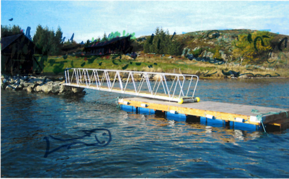
Bildet viser prinsipp av landgang til flytebrygger
