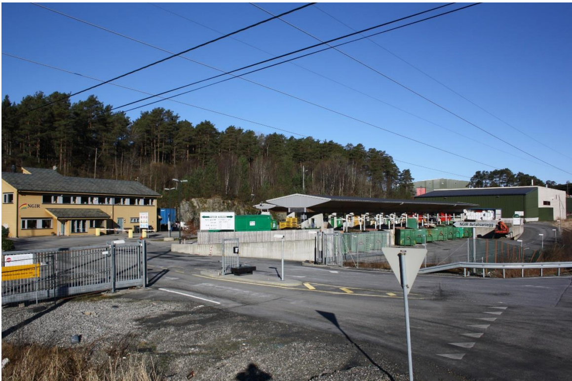
Figur 10: Eksisterande bygg innanfor planområdet.
