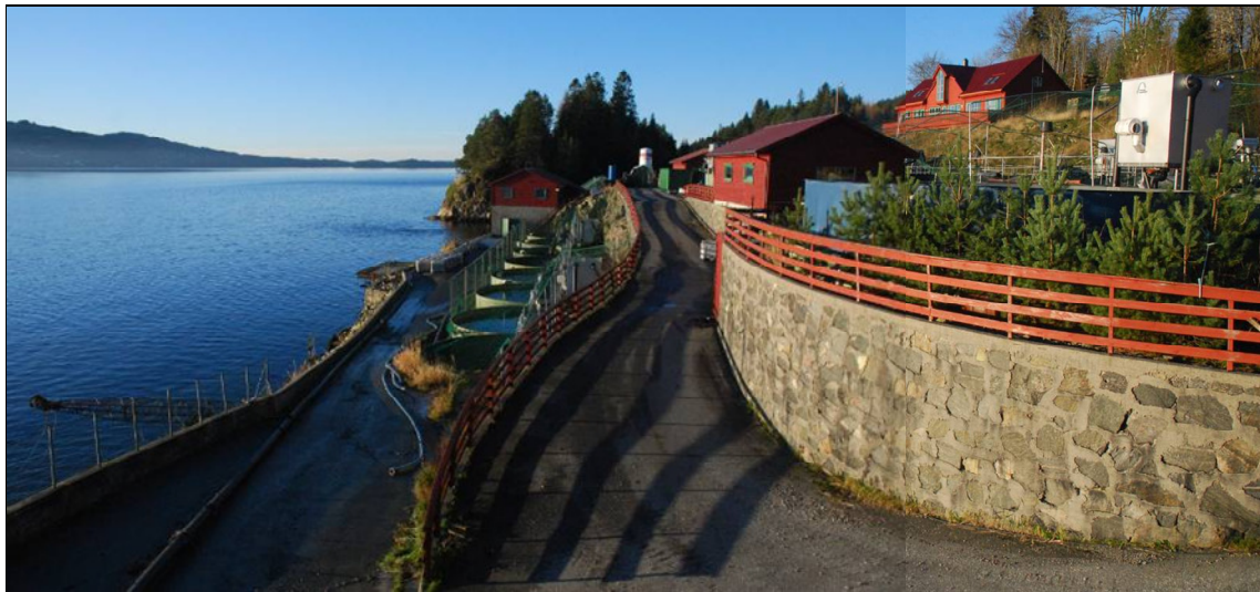
Figur 8. Anlegget på Nesfossen er bygget funksjonelt inn i det skrånende terrenget tilpasset sine omgivelser og har sitt utslipp til Lurefjorden.
