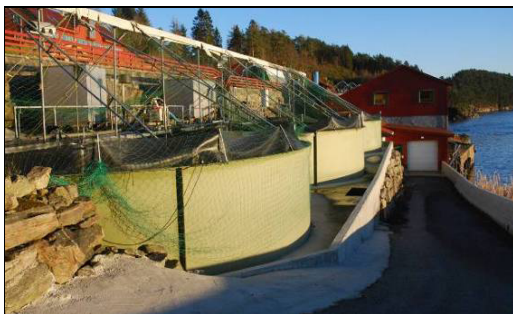
Figur 3. Øverst: Oversikt over omsøkt anleggskonfigurasjon med tilhørende bygninger og kar. Alle karene står under åpen himmel. Den doble kar-rekken med 20 stk 7 m kar ( midten til venstre ), 8 stk 7m kar ned mot sjøen ( midten til høyre ), tre stk 11 m kar nede ved sjøen ( nede til venstre ) og 5 stk 12 m kar sør på anleggsområdet. ( nede til høyre ).
