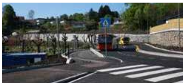
Kollektivfelt Foto: Statens vegvesen
