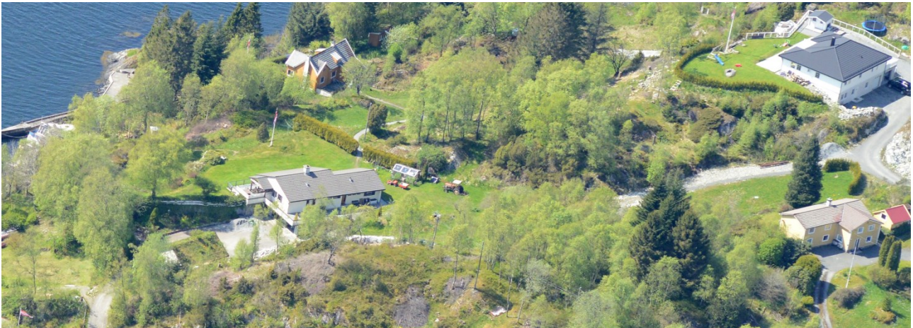
Flyfoto som viser at vegarbeidet er påbegynt
