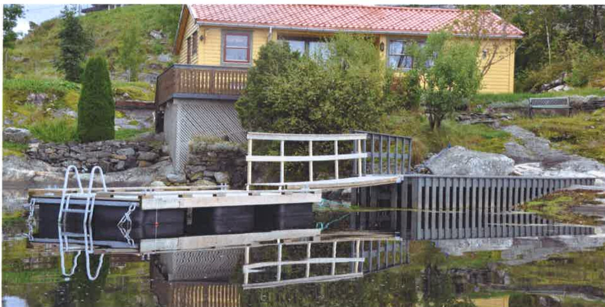
Løyve gitt 26.5.2014. Gangbro innbygget med rekkverk, flytebrygge med landgang.
