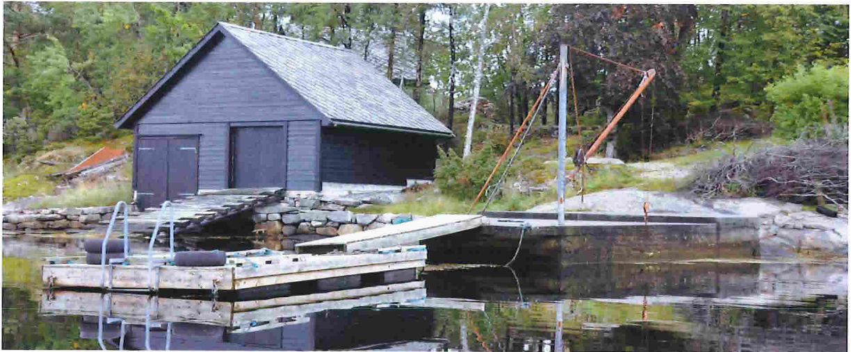
Støpt brygge med kran og flytebrygge med landgang
