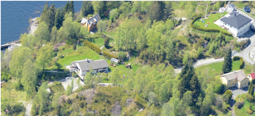
Flyfoto som viser at vegarbeidet er påbegynt
