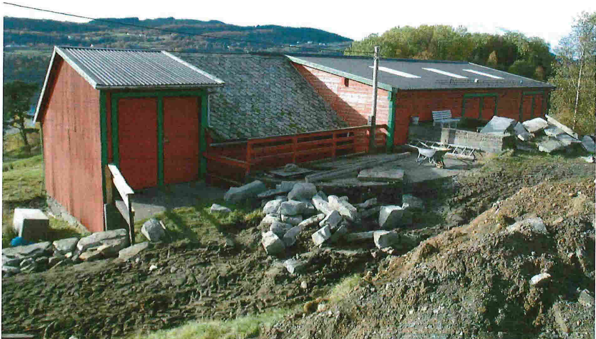
Fasade mot NORD-AUST
