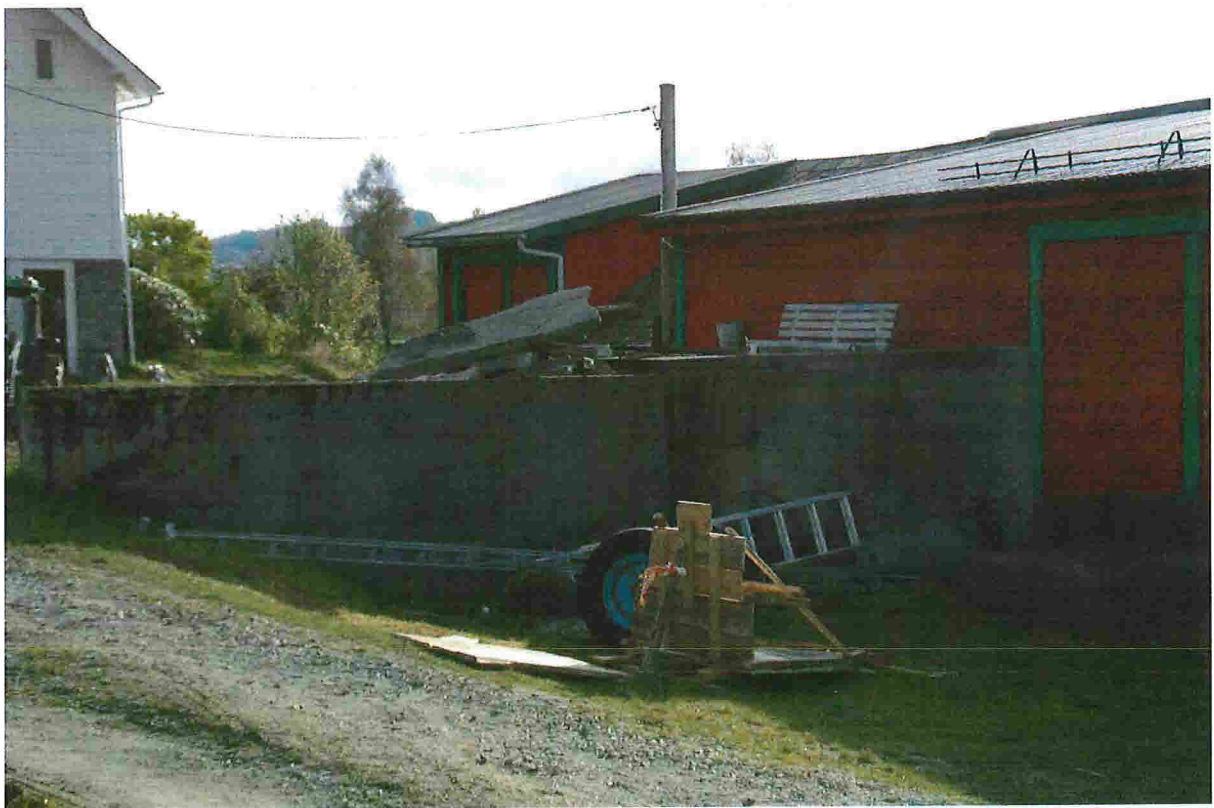
Fasade mot NORD-AUST
