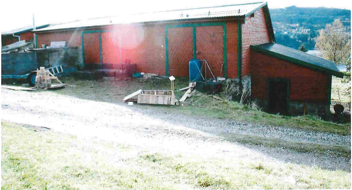
Fasade mot NORD-AUST
