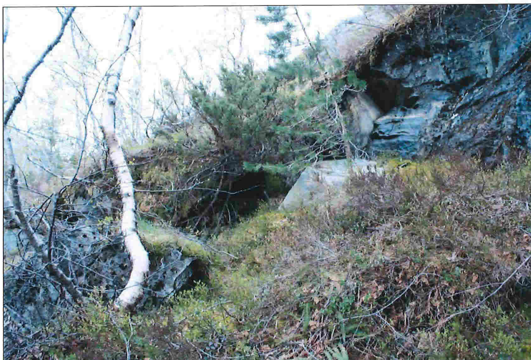
Fig. 10. Steinblokker som har løsnet og rullet noen meter nedover før de stoppet.
