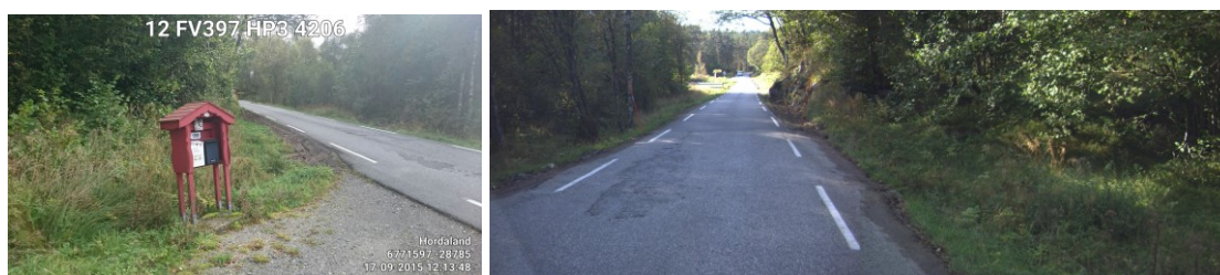
Postkassestativ, bergnabb og vegetasjon hindrer frisikt fra avkjørselen i retning vest.
