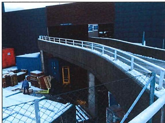
Teknisk meiner det vil la seg gjere å byggje ein lettkonstruksjon med sjøldrenerande dekke for fotgjengarane på nordsida av køyrebrua, men då må vi gjere inngrep i den private bygningskonstruksjonen til Knarvik senter. ( betongsage ny utgang + montering av ståldragere og dekke nord på utsida av brua ). Sjå bilete til venstre.
