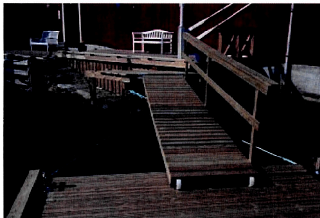
Landgang i trevirke med rekkverk på en side. Søkt landgang vil være lik denne.
