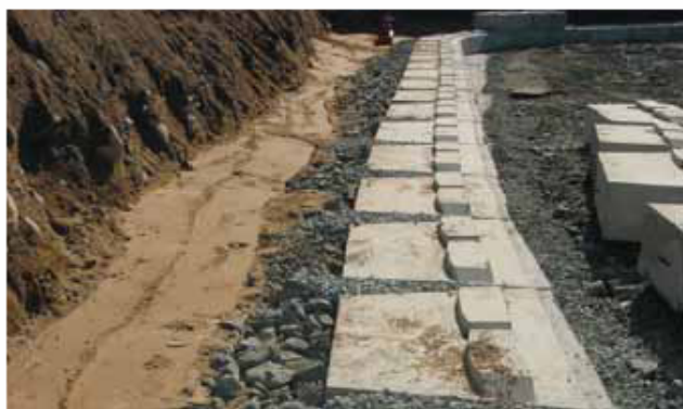
Drenering bak muren
