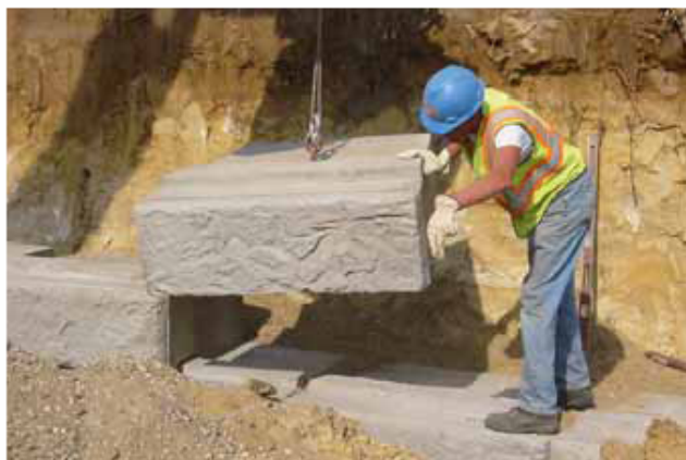
Plassering av blokk ved hjelp av løfteanker
