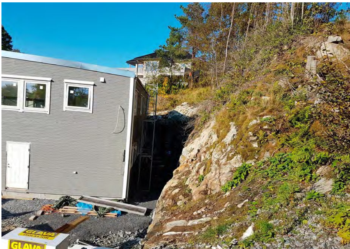
Tomannsbolig under oppføring på eiendom 23/528
